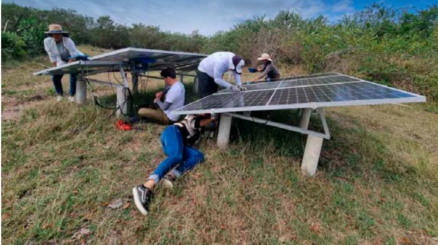
El montaje de paneles solares benefició a cerca de 3 000 habitantes en la provincia espinuana.
