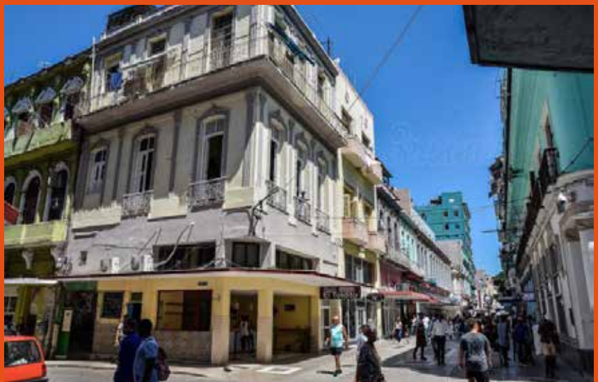
El proyecto incluye la rehabilitación del emblemático Cine Rex, en el boulevard de Centro Habana, popular paseo capitalino.
