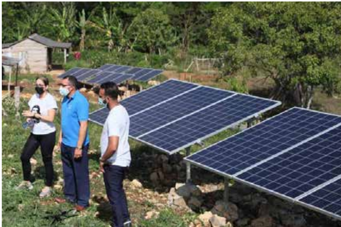
El empleo de paneles solares elevará la eficiencia en el bombeo de agua potable.
